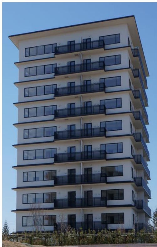
仙台の10階建の共同住宅 (鉄骨+CLT+燃エンウッド)
